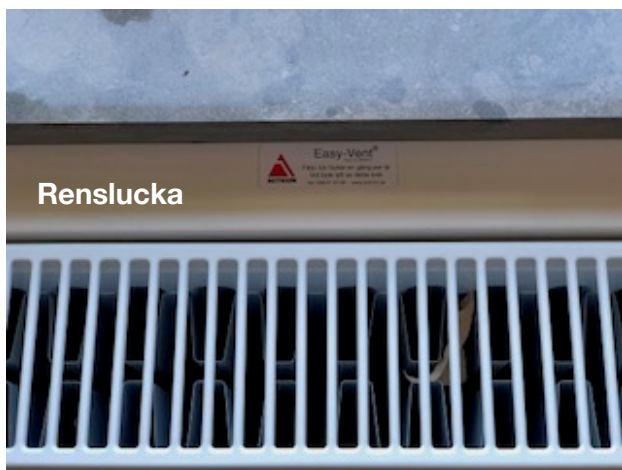
Bild 3, Rensluckan mellan element och fönsterbräda.
