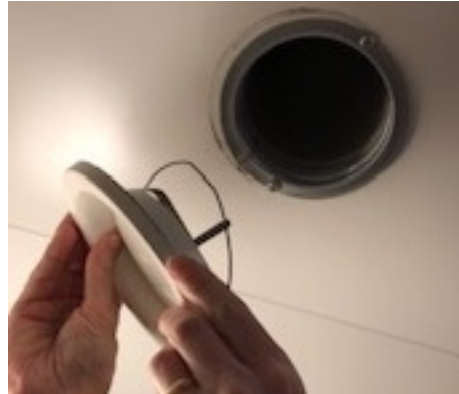
Bild 8, Donet har frånskilts från ventilationsröret.
